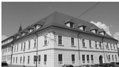
Vlastná budova školy (bývalá OA)
